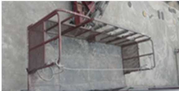
안전난간대 미설치 작업대에서 작업 중 떨어짐
