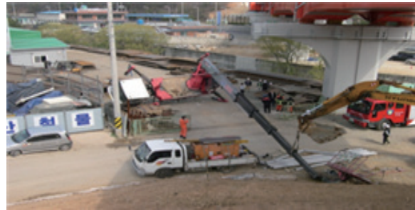
아웃트리거 설치 불량으로 전도
