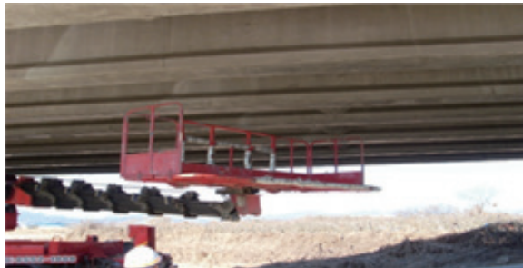
안전난간대 미설치 작업대에서 작업중 떨어짐
