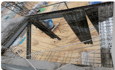
콘크리트 타설 중 데크플레이트를 지지하던 각재 받침이 탈락되며 데크 플레이트가 붕괴, 3명 사망('19. 3. 18, 경북 안동)
