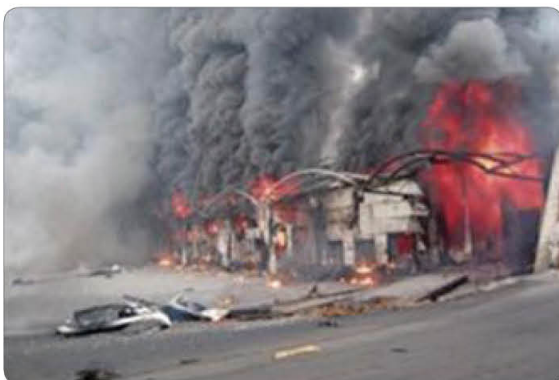
미천 물류 냉동창고 신축공사 화재 ('08.1.7. 사망 40, 부상 10)
