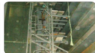
고소작업(안전난간 미설치)
