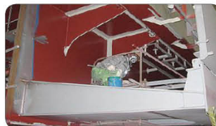
도장작업(안전난간 미설치)
