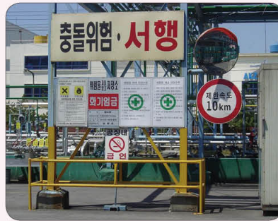
제한속도 지정 및 사각지대 반사경 설치
