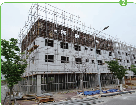
‘추락위험장소’에 작업발판이 설치되지 않은 모습
