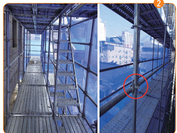
추락방지용 작업발판이 설치된 시스템비계의 모습
