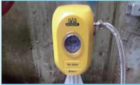
집수조 내 가스검지기 설치
