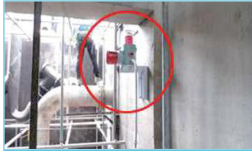
집수조 하부 경광등 설치
