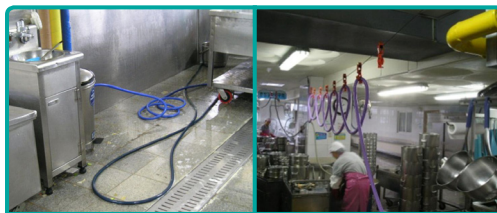
호스를 벽상부에 릴 형태로 설치·사용
