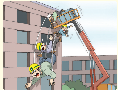
상부 작업대가 흔들려 떨어짐
