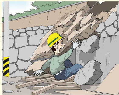
옹벽 시공 중 굴착면 무너짐
