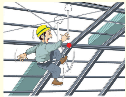
지붕 판넬 작업 중 떨어짐
