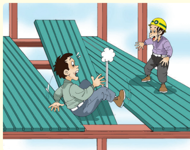
데크플레이트 설치 작업 중 떨어짐
