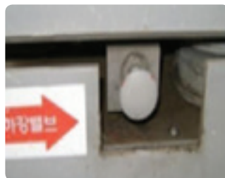
Ослоос хамгаалах төхөөрөмж(Буулгагч хавхлага) 비상안전장치(하강밸브)
