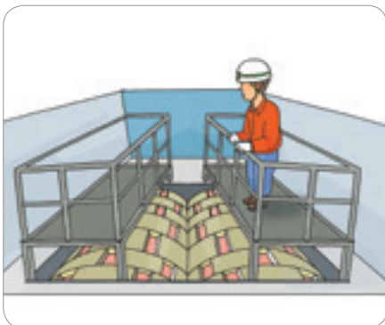
ငြိမ်းစင်အနားရှိ ဘေးကင်းရေး လက်တန်းများ 작업발판 및 안전난간 설치
