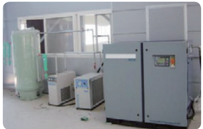
වායු ටැංකිය සහ භ්‍රමණ ඉස්කුරුප්පු වායු සම්පීඩකය 스크류 타입 공기압축기 및 공기저장탱크
