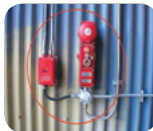
Учқун чиқармайдиган ёнғин сигнализацияси 방폭형 화재발신기
