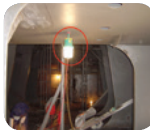
Penerangan sementara tahan api 방폭형 임시 조명등
