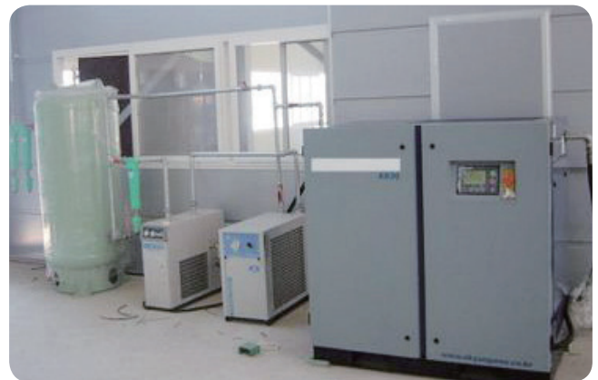
Kompresor udara sekrup putar dengan tangki udara 스크류 타입 공기압축기 및 공기저장탱크
