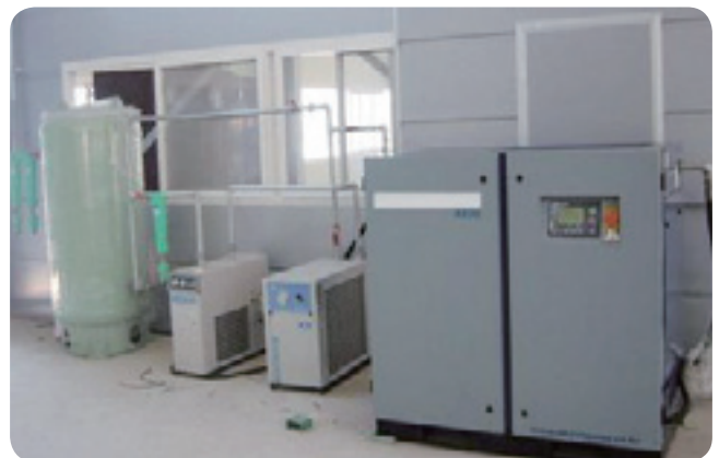
ម៉ាស៊ីនបង្ហាប់ខ្យល់ប្រភេទវិស័យជាមួយនឹងធុងខ្យល់ 스크류 타입 공기압축기 및 공기저장탱크
