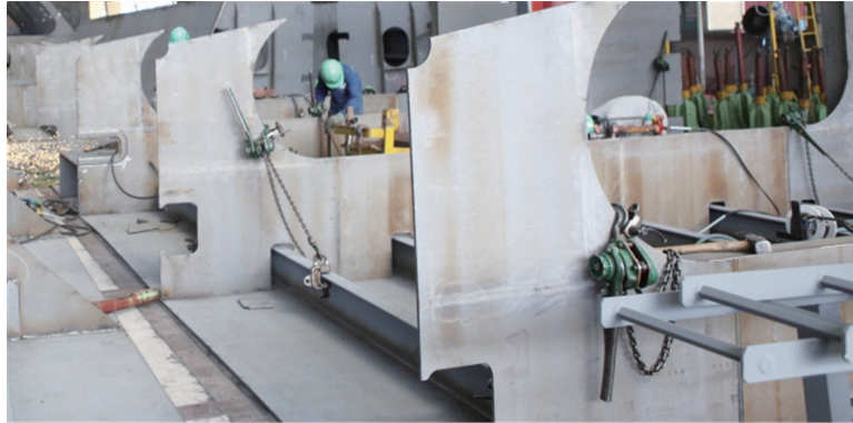
<Vận hành sử dụng đòn bẩy> (레버풀러를 이용한 작업)
