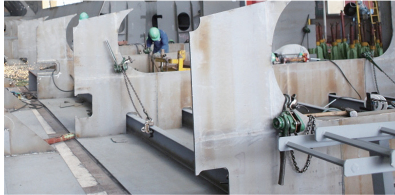
<Operasi Menggunakan Penarik Tuas> (레버풀러를 이용한 작업)
