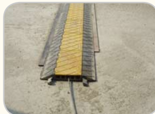
바닥 보호대 설치
