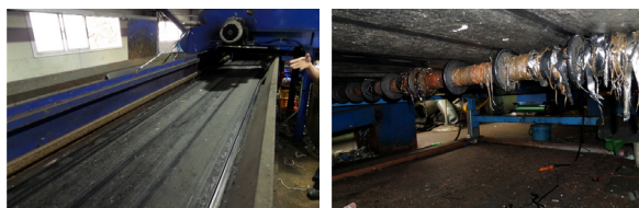
〈고속 컨베이어벨트 및 하부 가이드롤러 상태〉
