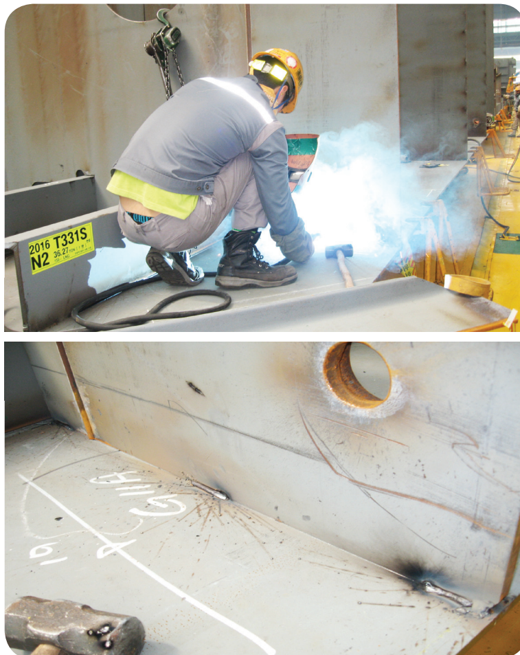
조선소 블록 작업 시의 가용접(Tack Welding, 일명 취부작업[取付作業]이라고 함)
