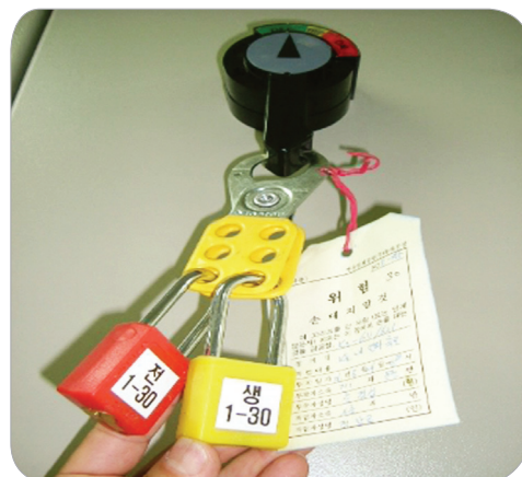
기동스위치 잠금장치 설치
