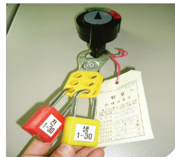
기동스위치 잠금장치 설치
