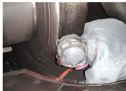
미분기 내부 금속보수재 Filling
