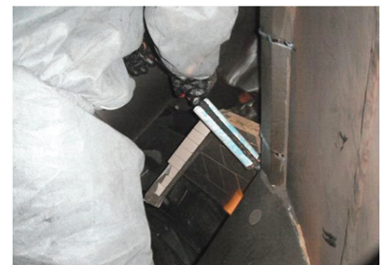
미분기 내부 Liner 틈새 실리콘 Filling
