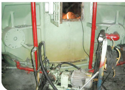
작업 전 상부 Manhole Open으로 환기
