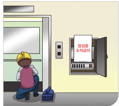
점검 시 해당 전원 차단
