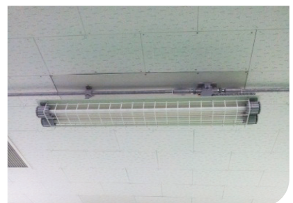
방폭형 전등 설치
