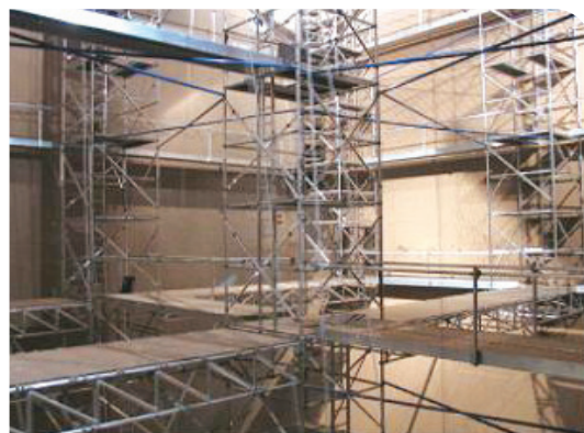
보일러 노내 점검용 비계 설치 모습
