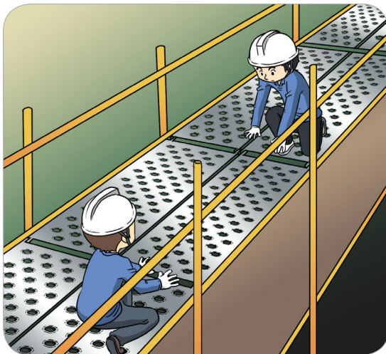
작업대의 발판을 빈틈없이 설치
