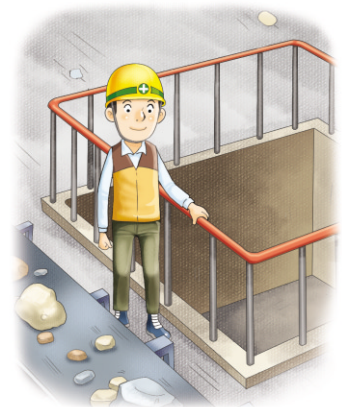
이동용 통로 안전난간 설치
