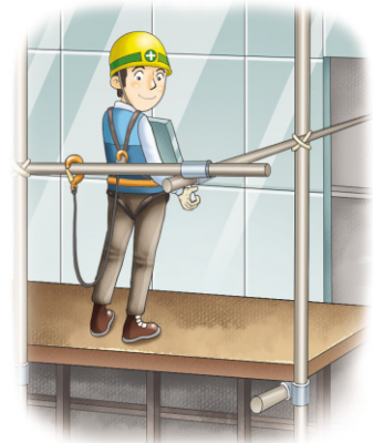
비계 설치 시 안전난간 부착
