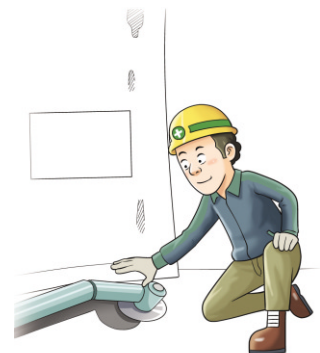
고압호스 손상여부 확인
