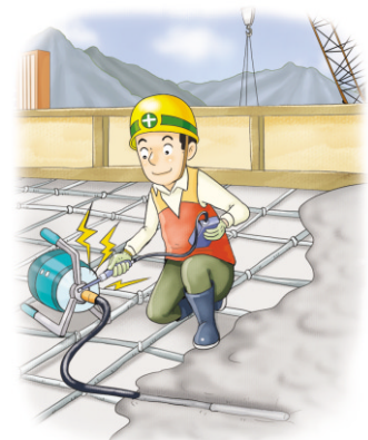
사용 전 누설 전류 측정
