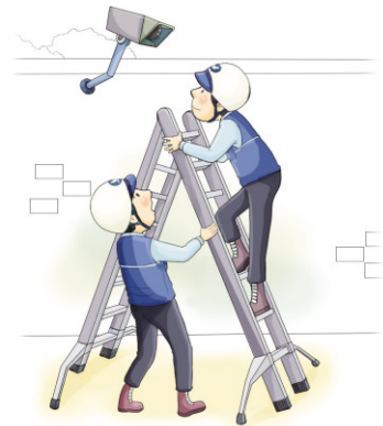
사다리 작업 시 2인 1조 작업 실시
