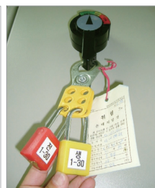
메인스위치 시건장치 설치
