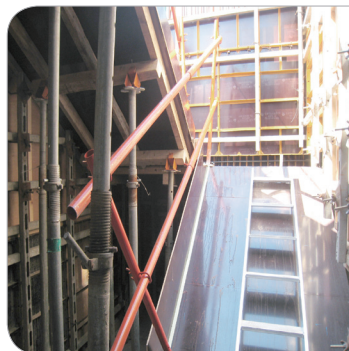
계단실 안전난간(시공 중)
