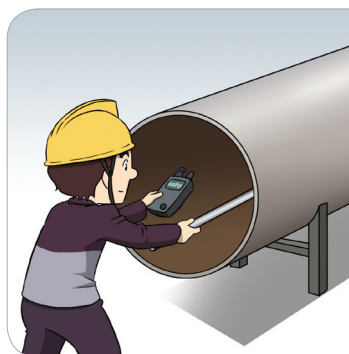
작업 전 산소농도 측정
