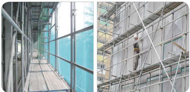
쌍줄비계의 작업발판 및 안전난간 설치상태
