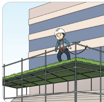
안전대 부착설비 설치
