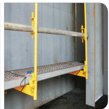
안전 난간대 설치
