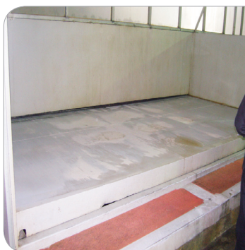
호퍼 덮개 설치
