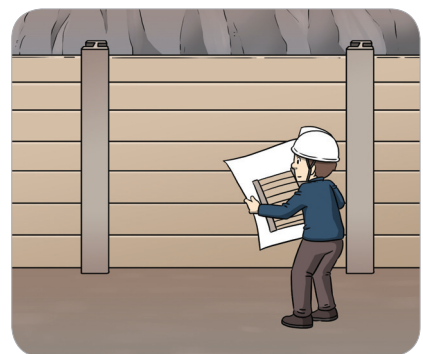
흙막이 지보공 설치
