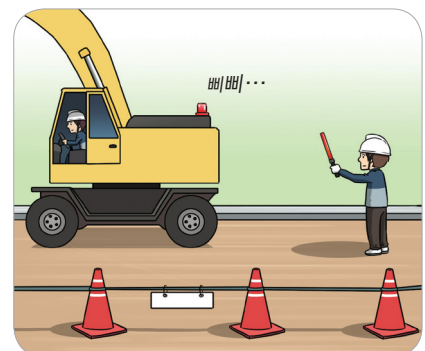
후진 경보음 설치 및 작업지휘자 배치
