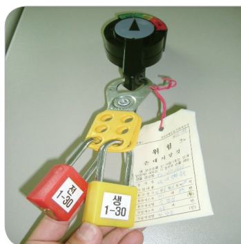
스위치 시건장치 설치
