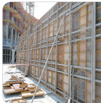
전도방지용 지지대 설치
